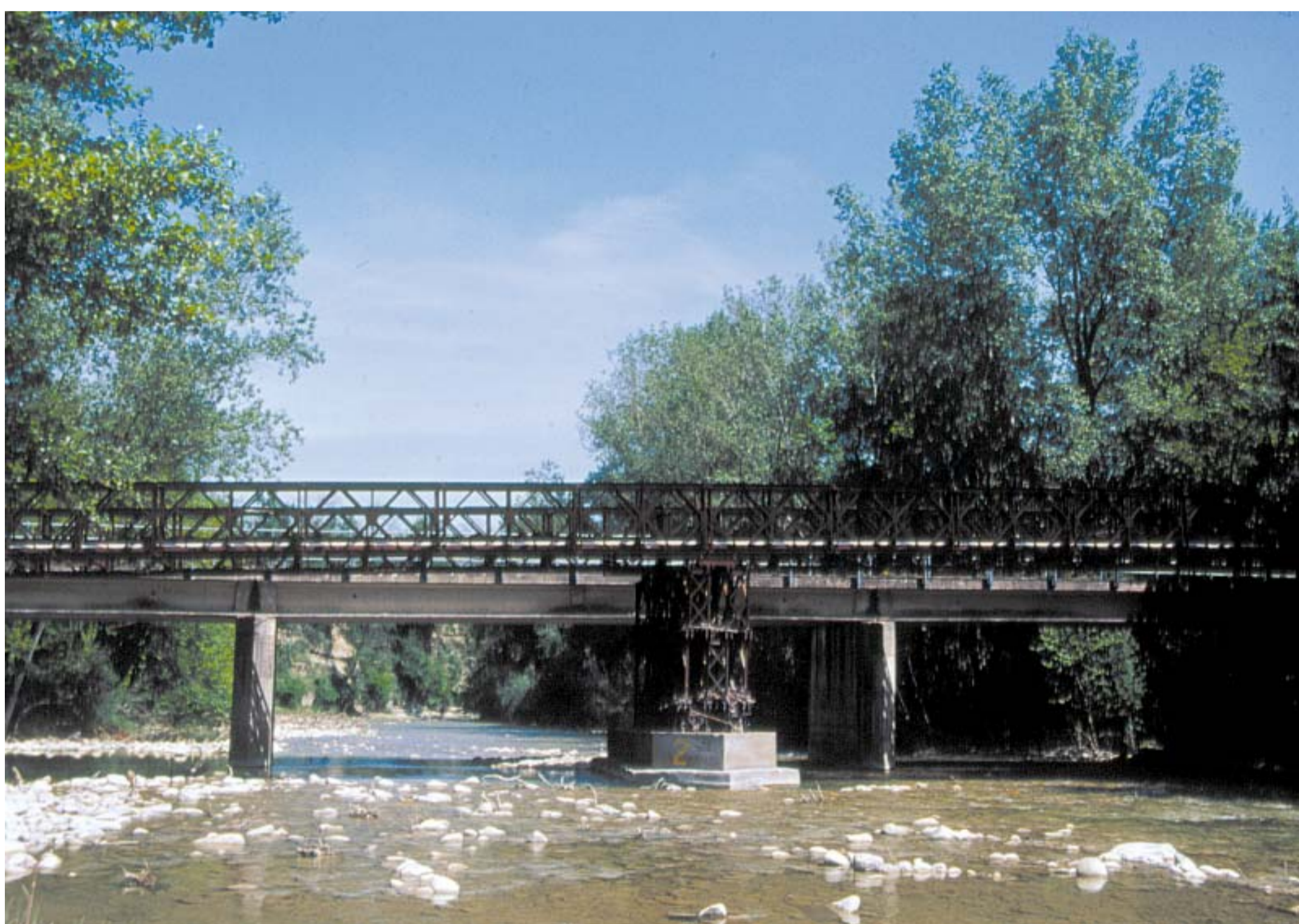
Ponte Bailey sul fiume Santerno a Carseggio (foto A.M. Guccini)
