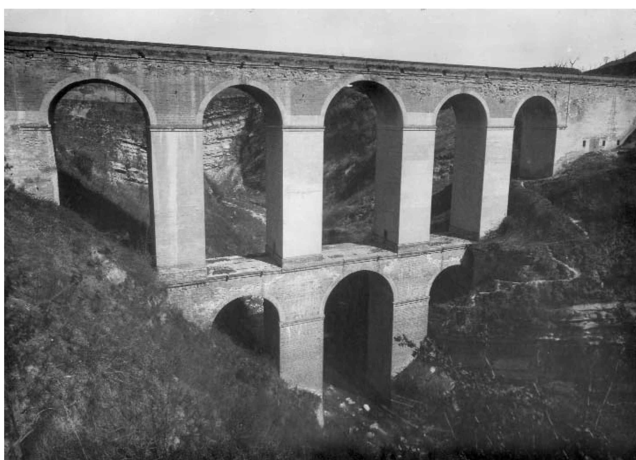
Il ponte di Gaggio ricostruito dopo il crollo del 1848 (ASPB)
