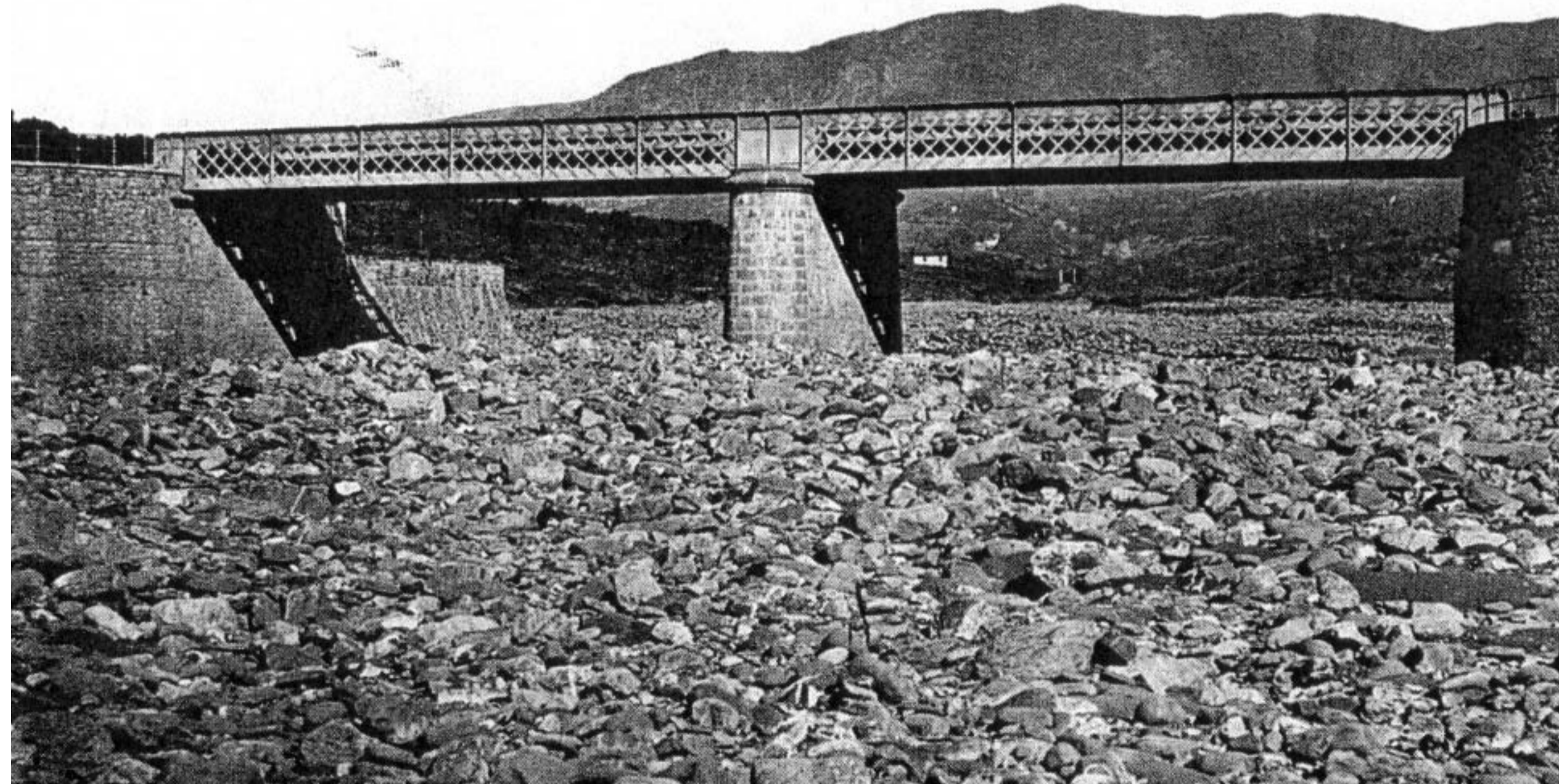
Foto del ponte in ferro, muratura e legno sul torrente Silla sull'antica strada Porrettana
