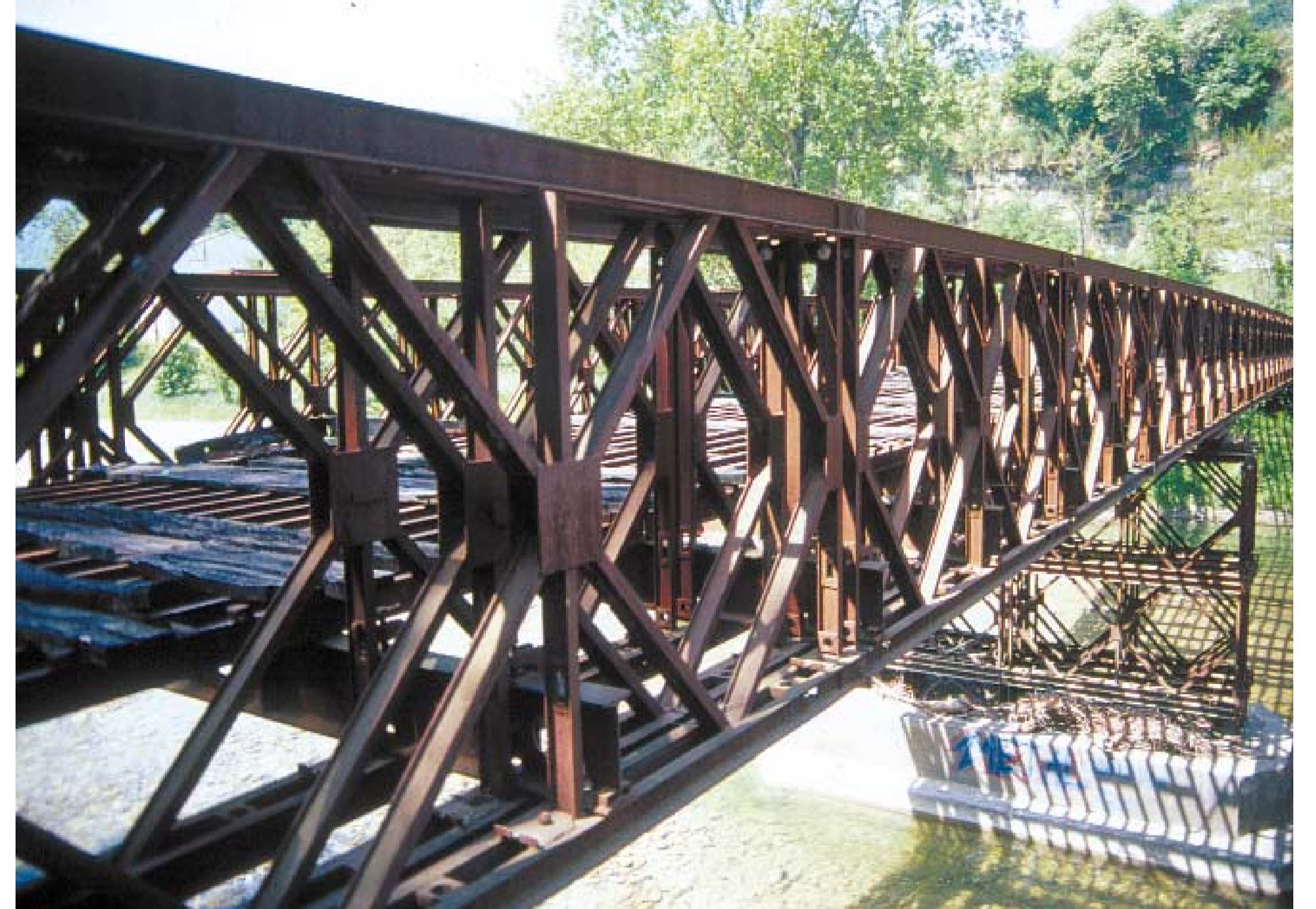
Particolare della travata del ponte Bailey di Carseggio (foto A.M. Guccini)
