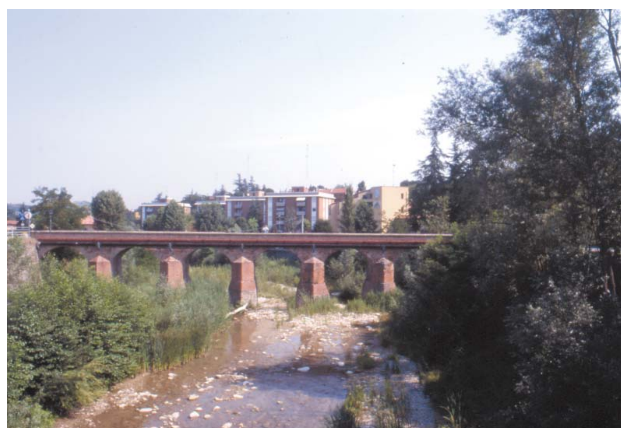
Il ponte di Pianoro Vecchio oggi ridotto solo all'uso pedonale (foto S.Venturi-IBC)
