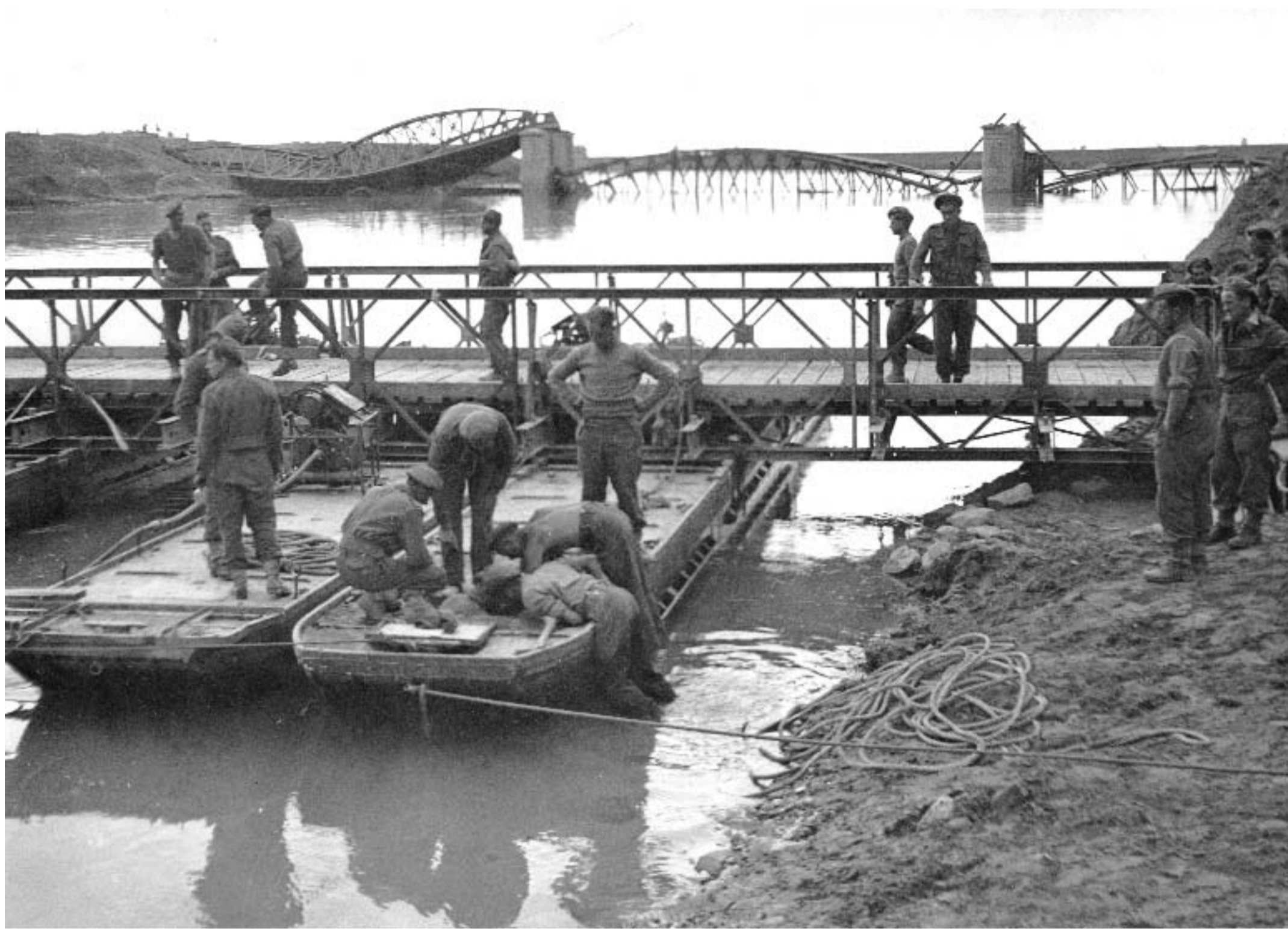
Un ponte Bailey galleggiante sostituisce il ponte ferroviario distrutto sul Reno, presso Tragheto di Molinella (Imperial War Museum-Arch. IBC)
