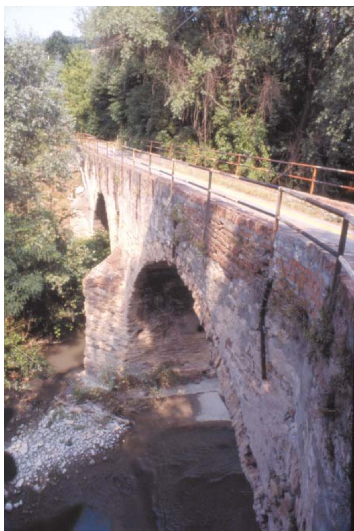
Ponte, detto "Il Paleotto", sul Savena a Rastignano di Pianoro, forse costruito verso la fine del Cinquecento dalla facoltosa famiglia bolognese (foto S.Venturi-IBC)
