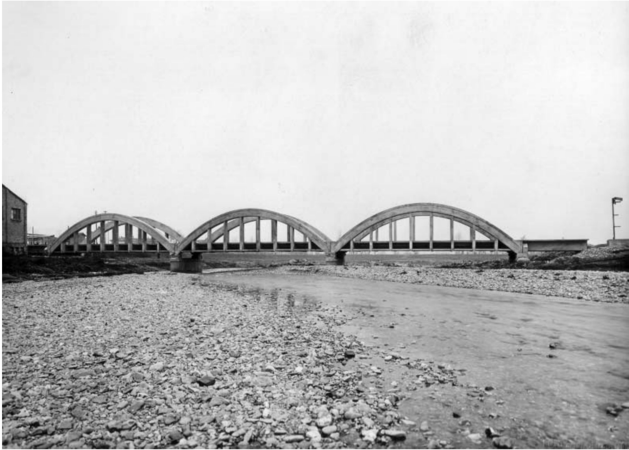
Ponte sul torrente Samoggia, della ferrovia Casalecchio Vignola (ASPB)
