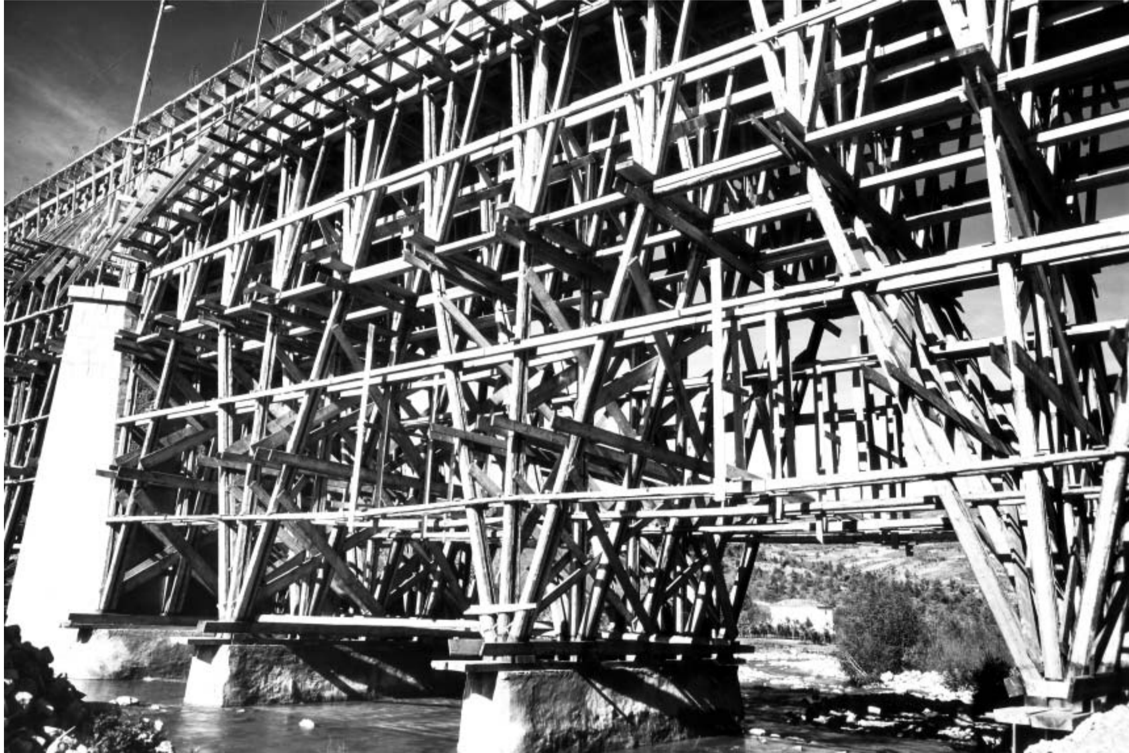
Particolare dell'armatura lignea dell'arcata centrale del ponte sul torrente Dardagna (Foto Studio A. Villani, Bologna, anno 1949-ARER)
