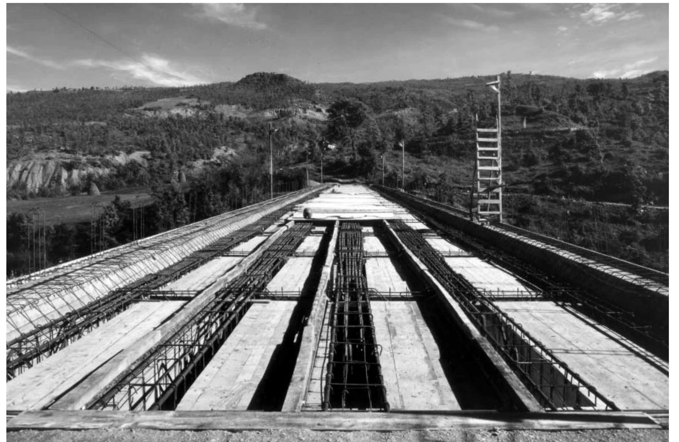
Particolare dell'impalcato del ponte sul Dardagna (Foto Studio A. Villani, Bologna, anno 1949-ARER)
