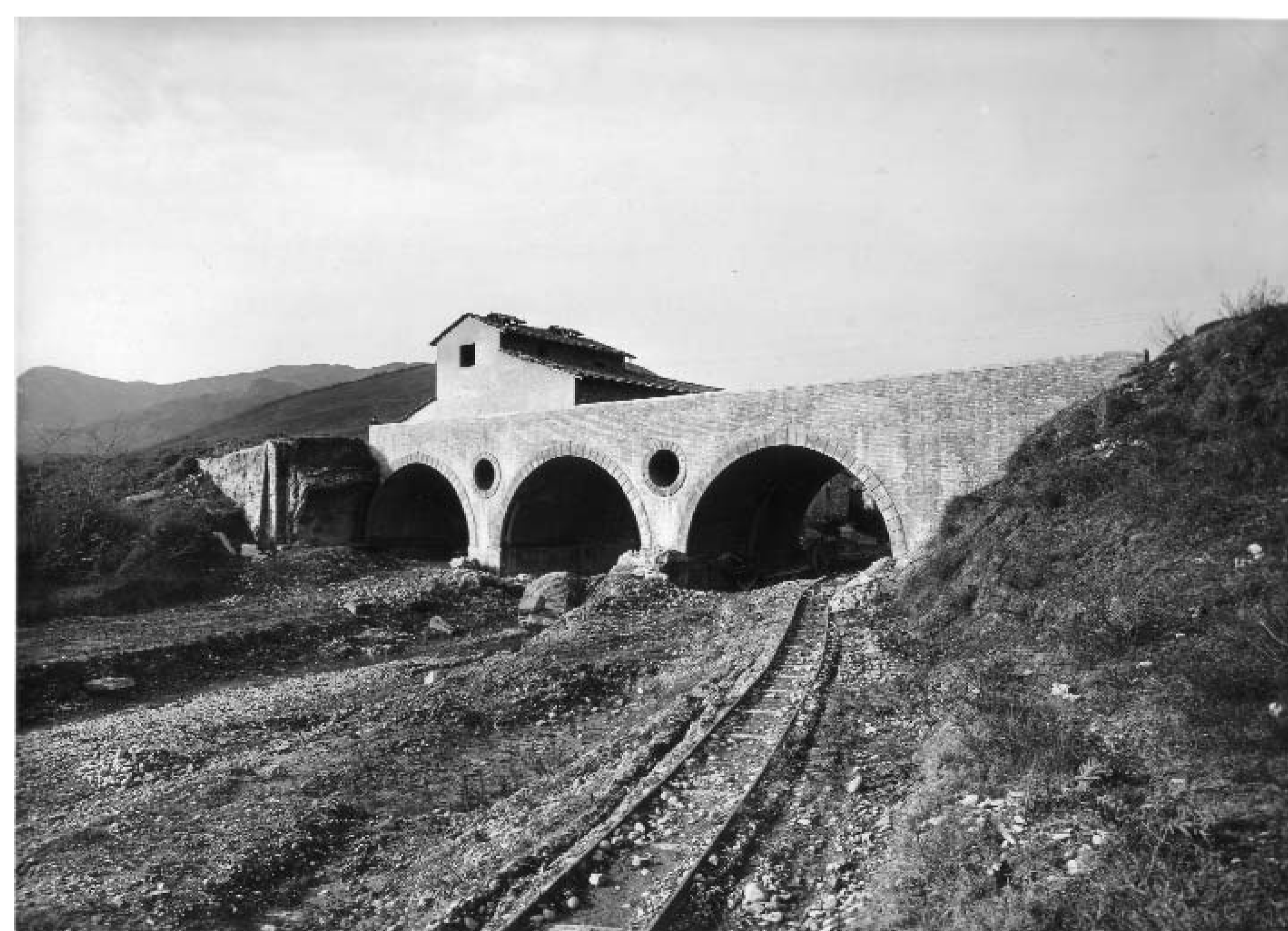
Il ponte ricostruito sul rio Mescola a Borgo Tossignano (ASPB)
