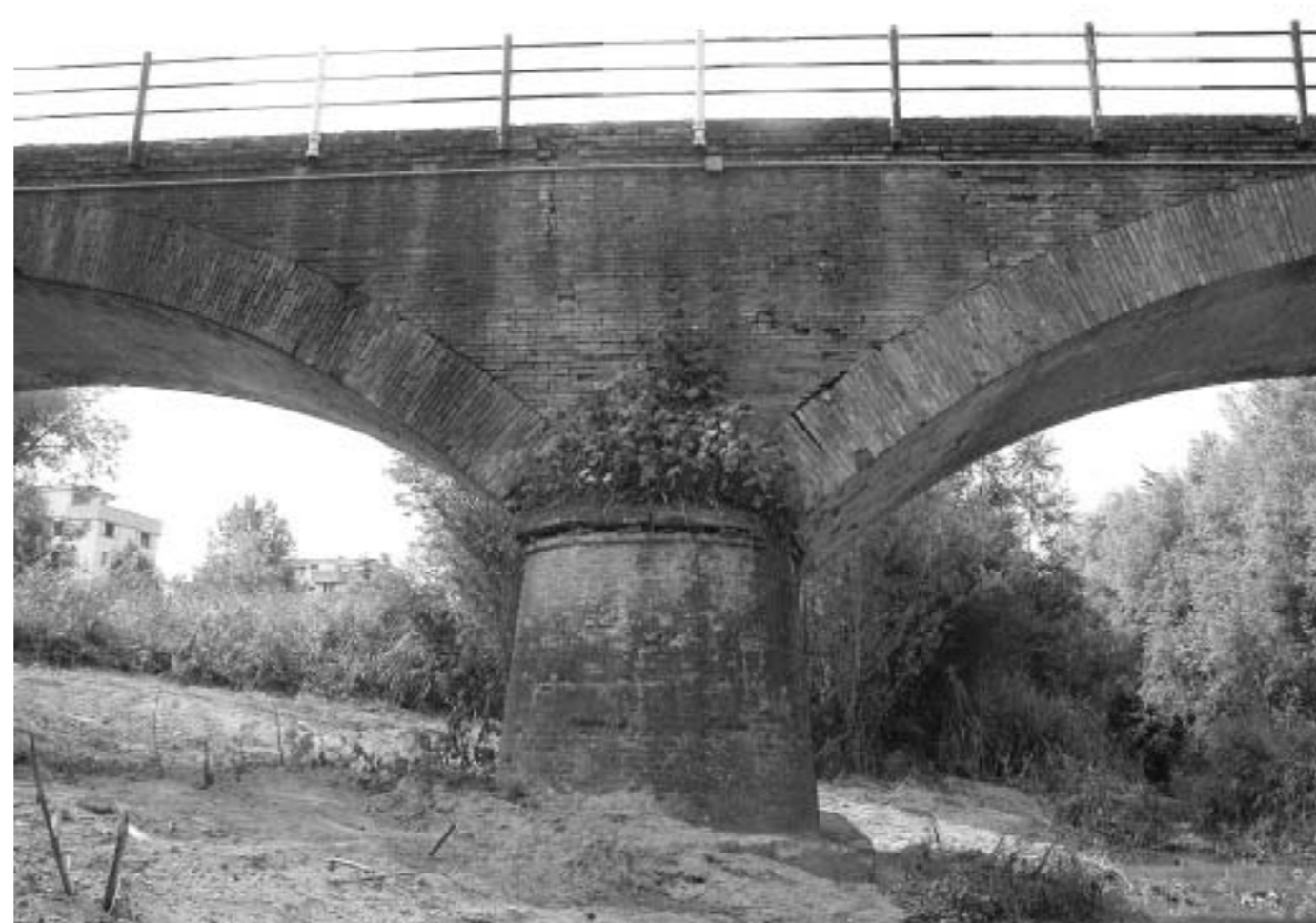
Ponte di Pian di Macina (foto Provincia di Bologna)
