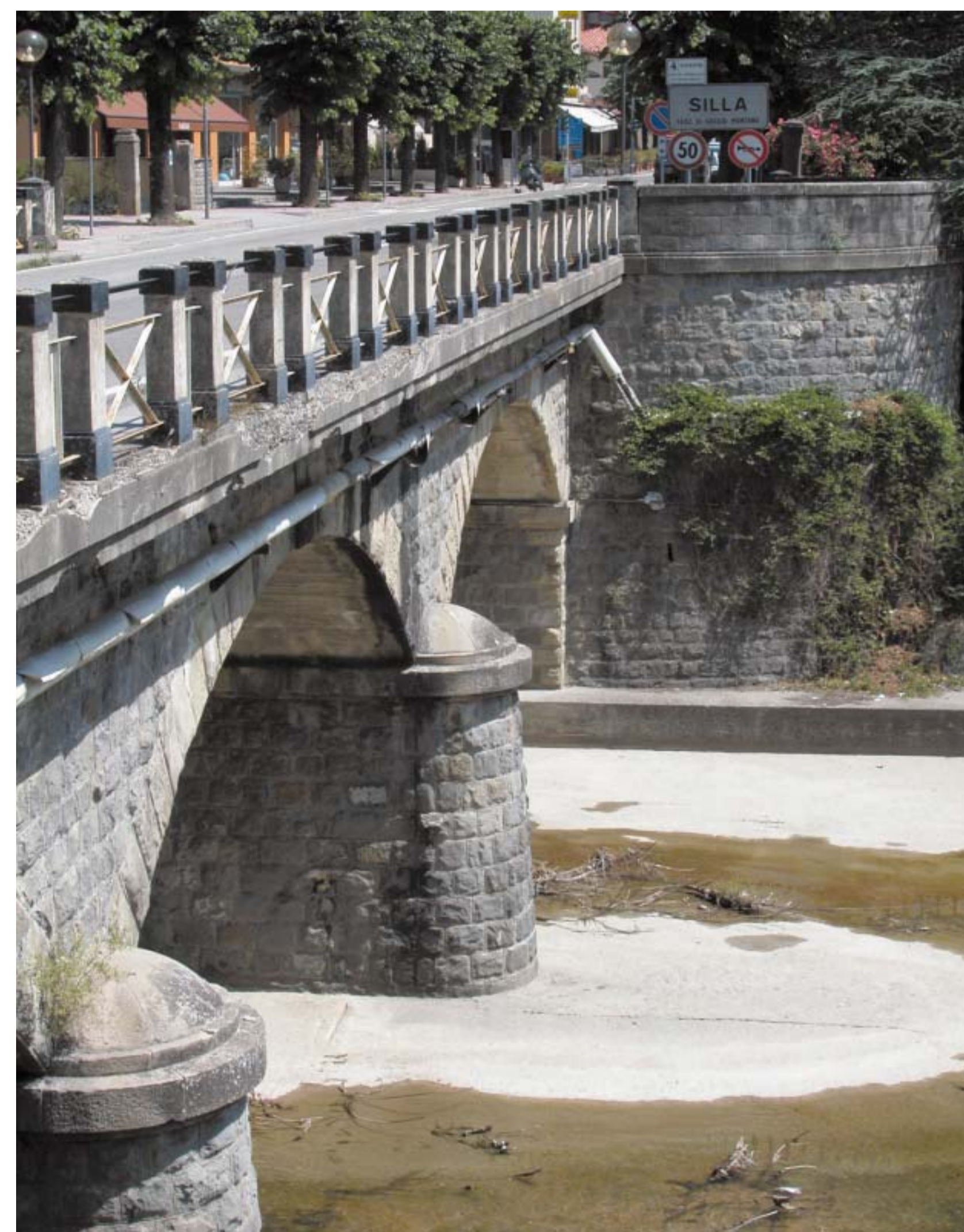
Scorcio del ponte sul torrente Silla ripreso dalla semirotonda sinistra verso valle (foto R. Vlahov-IBC)
