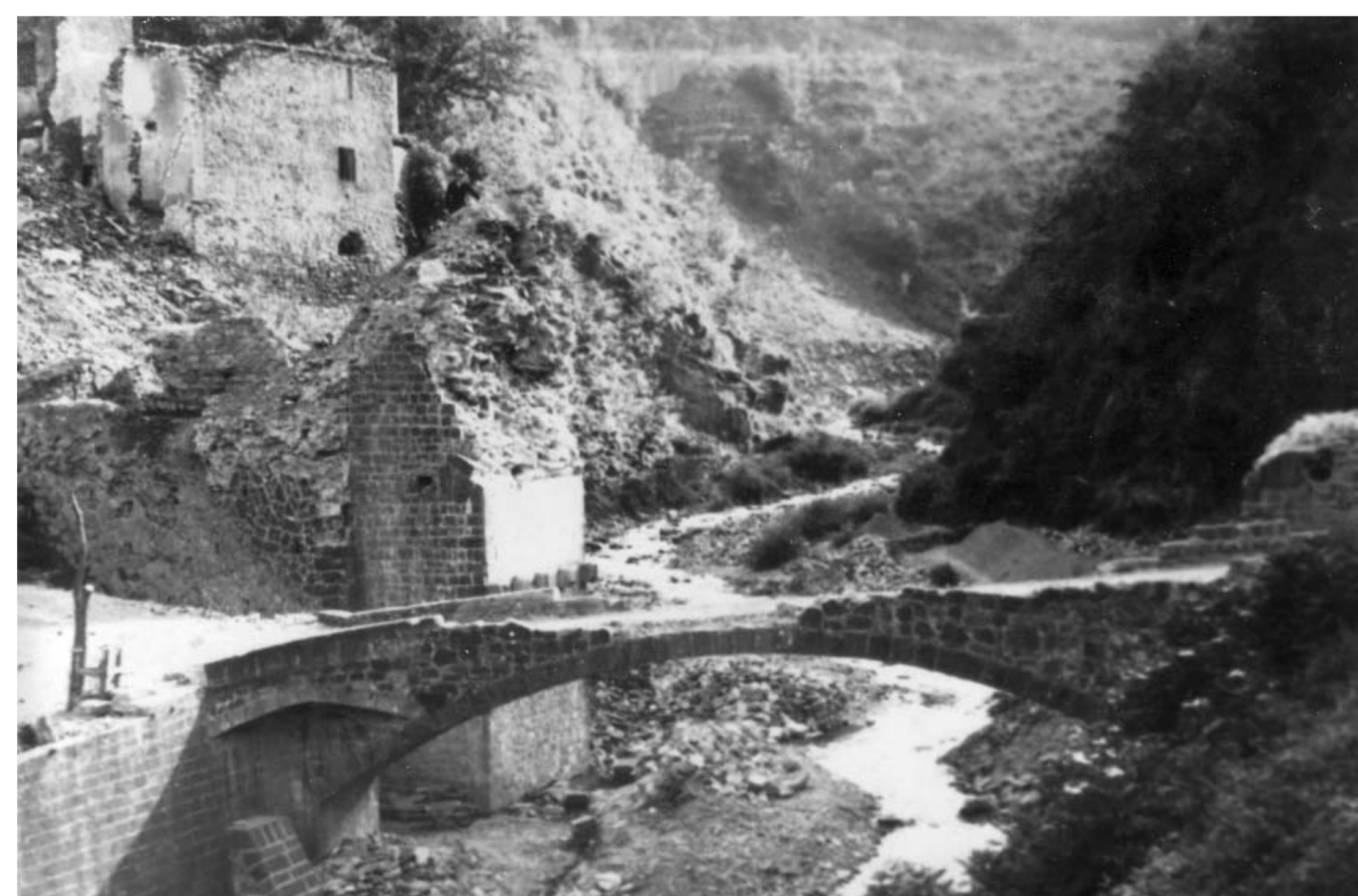
Il ponte della strada comunale (ASPB)
