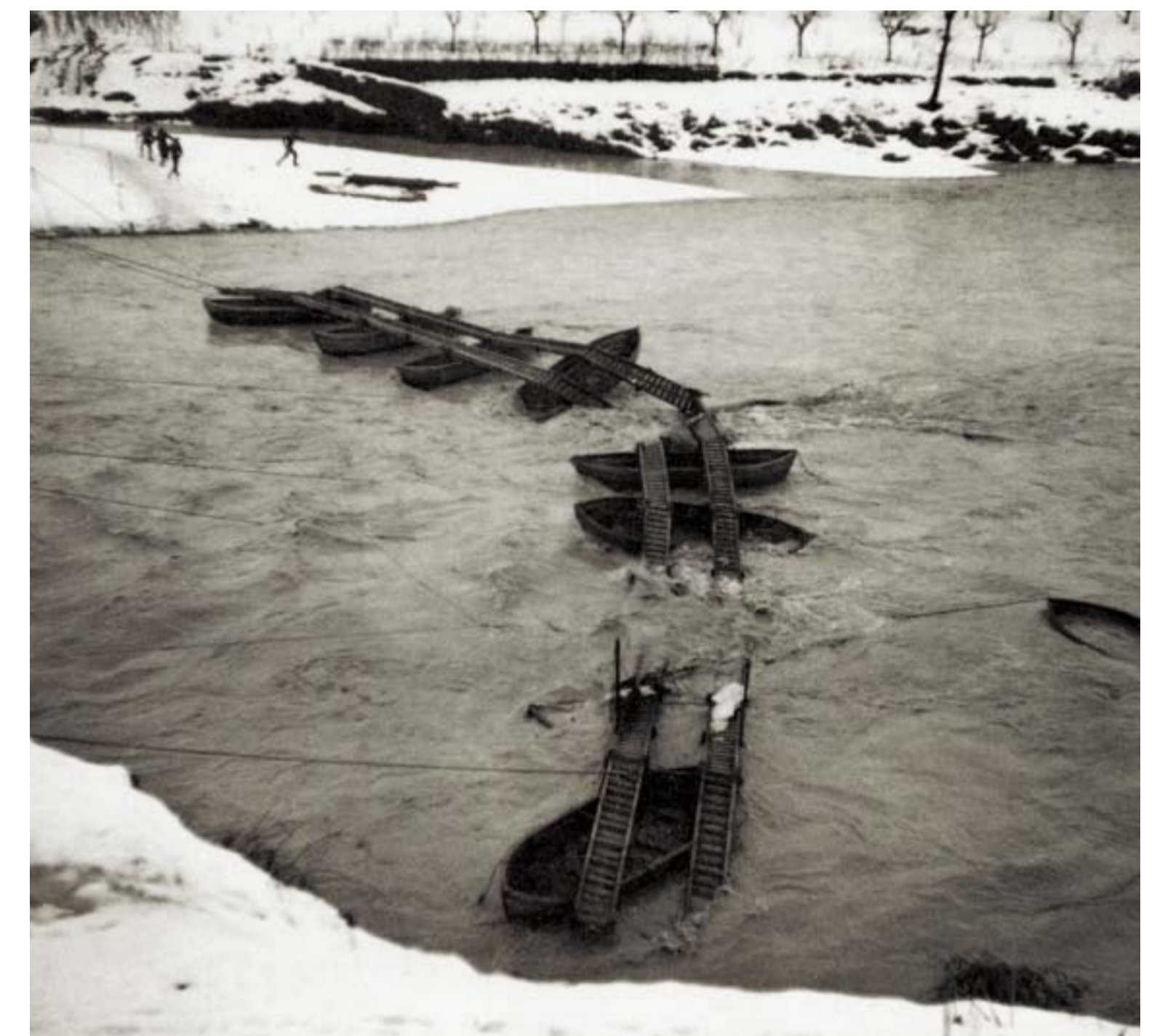
Rottura di un precario e fragile ponte su chiatte sul Santerno presso Fontanelice nel gennaio 1945 (foto I.W.M. London)
