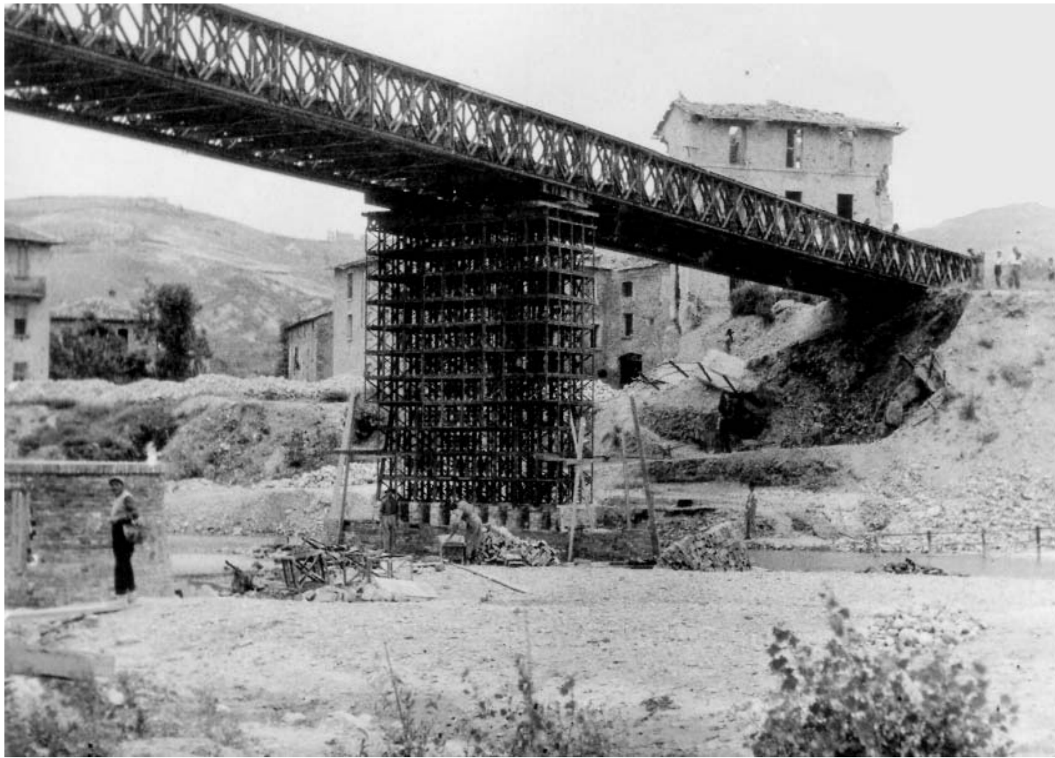
Il ponte Bailey sul fiume Santerno a Borgo Tossignano (ASPB)
