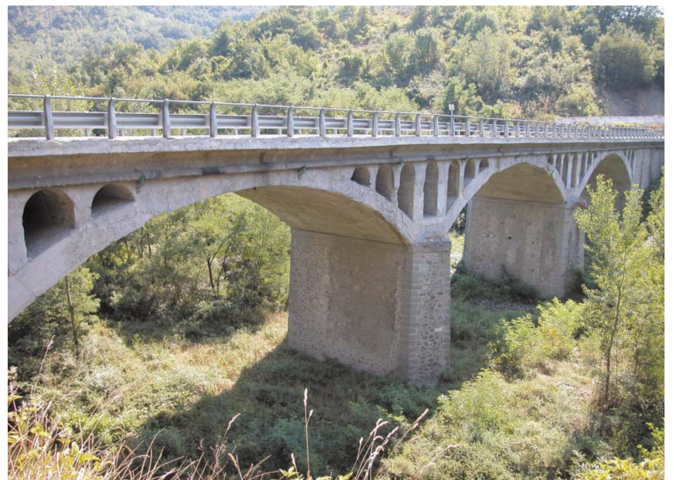
Ponte sul torrente Brasimone (foto R. Vlahov-IBC)
