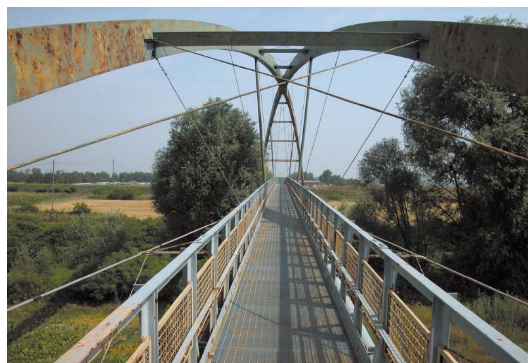
Una moderna passerella sospesa, dalla elegante struttura, attraversa il Reno presso Marmorta di Argenta (foto R.Vlahov-IBC)
