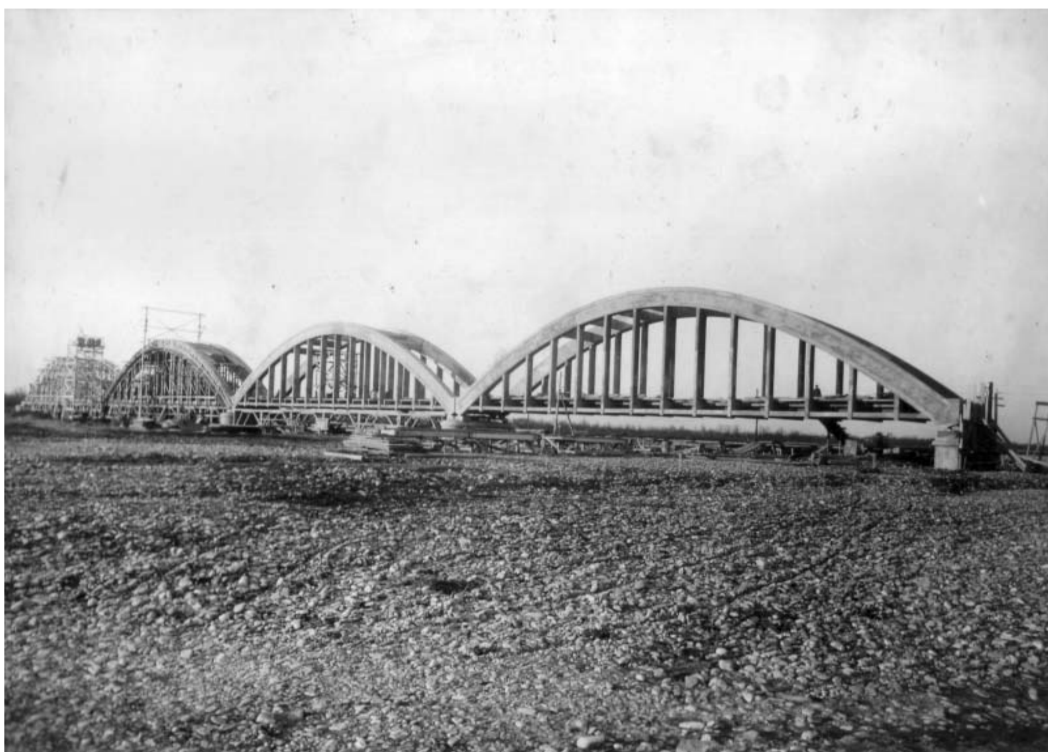
Il ponte sul Panaro in fase di ultimazione (ASPB)
