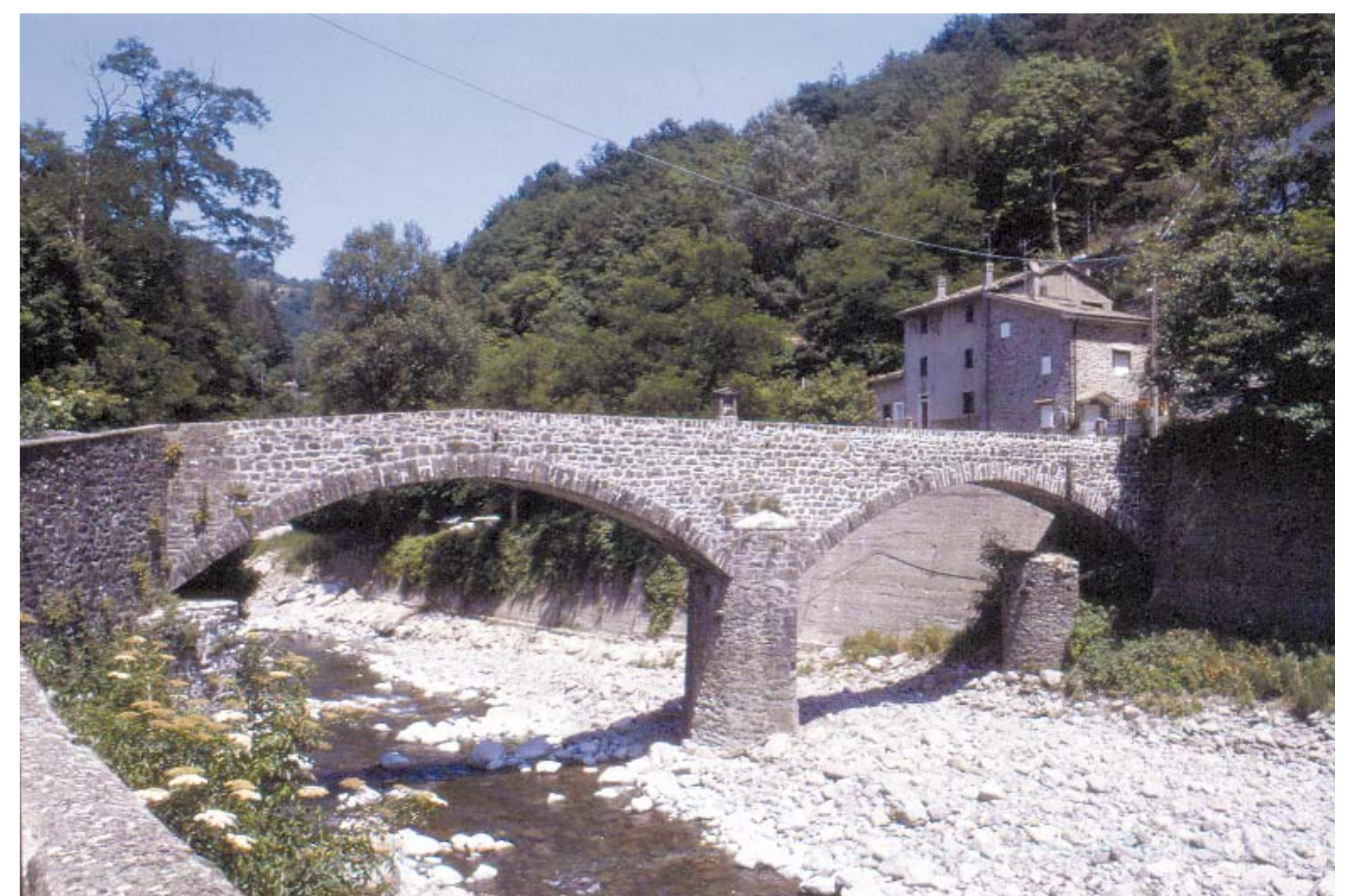
Il ponte a Biagioni di Granaglione costruito probabilmente nell'Ottocento (foto S.Venturi-IBC)
