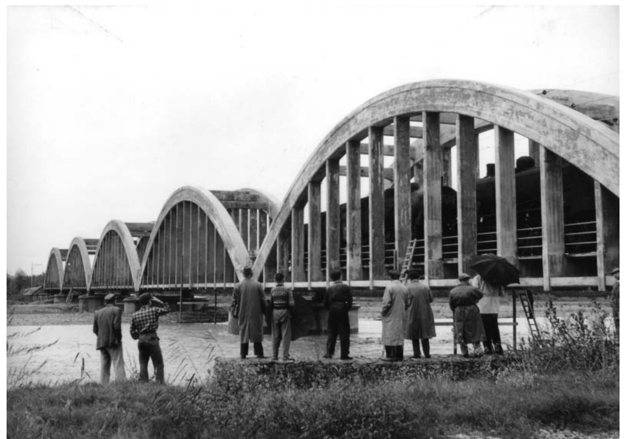
Collaudo dell'opera del ponte sul fiume Panaro, 7 ottobre 1955 (foto Enrico Pasquali-ASPB)
