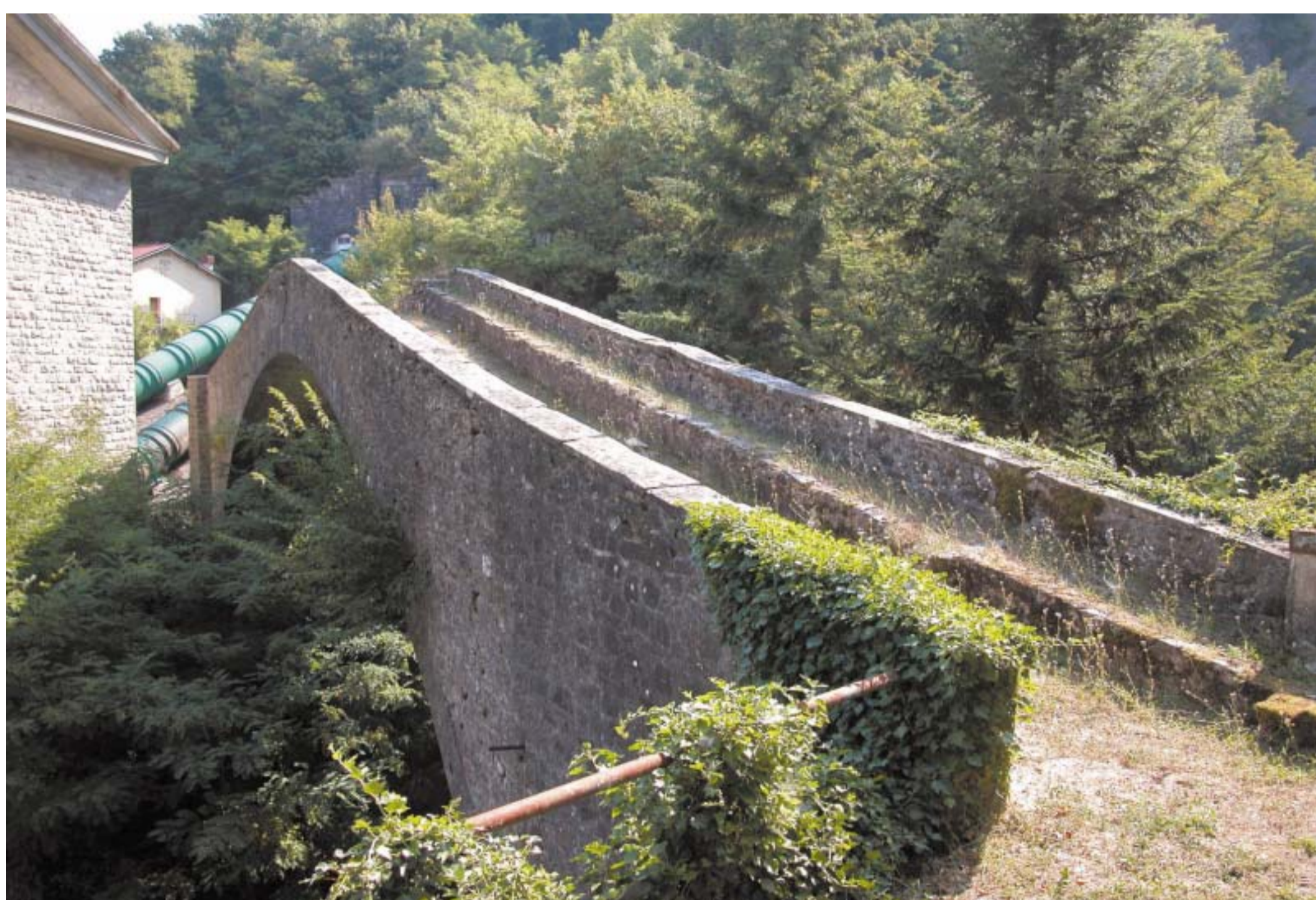
Il ponte a schiena d'asino, costruito nel 1766, risparmiato durante la costruzione della diga di Suviana (foto R.Vlahov-IBC)
