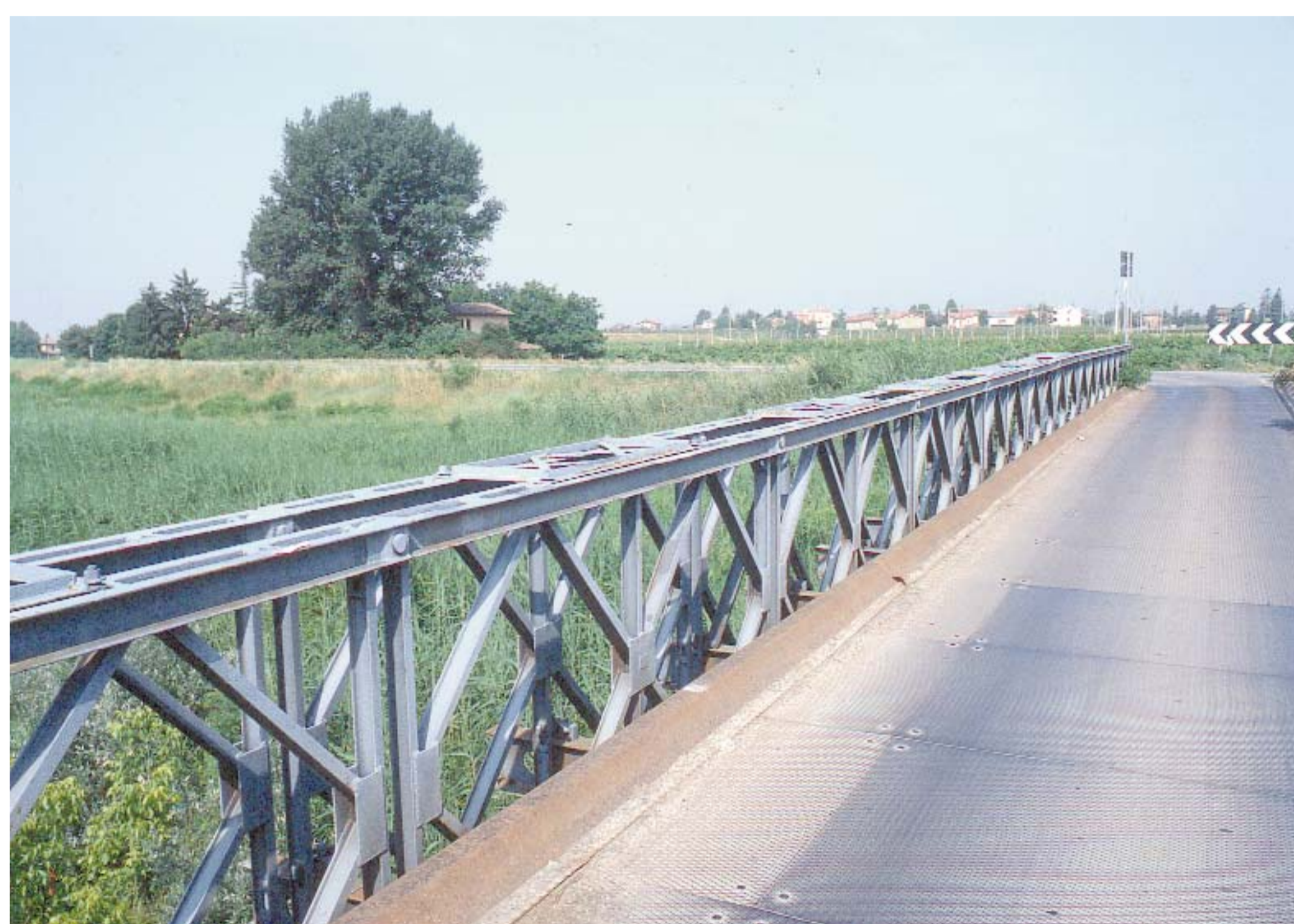
Ponte Bailey sul Samoggia a S. Maria in Strada (foto S. Venturi-IBC)
