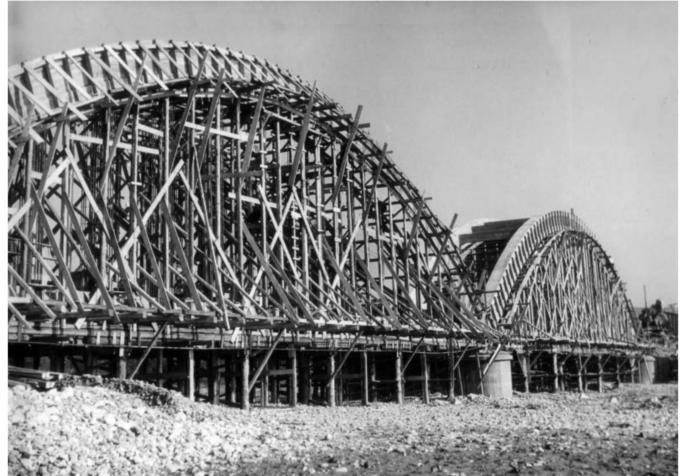
Armature di due arcate del ponte sul fiume Panaro, della ferrovia Casalecchio Vignola (foto Enrico Pasquali-ASPB)
