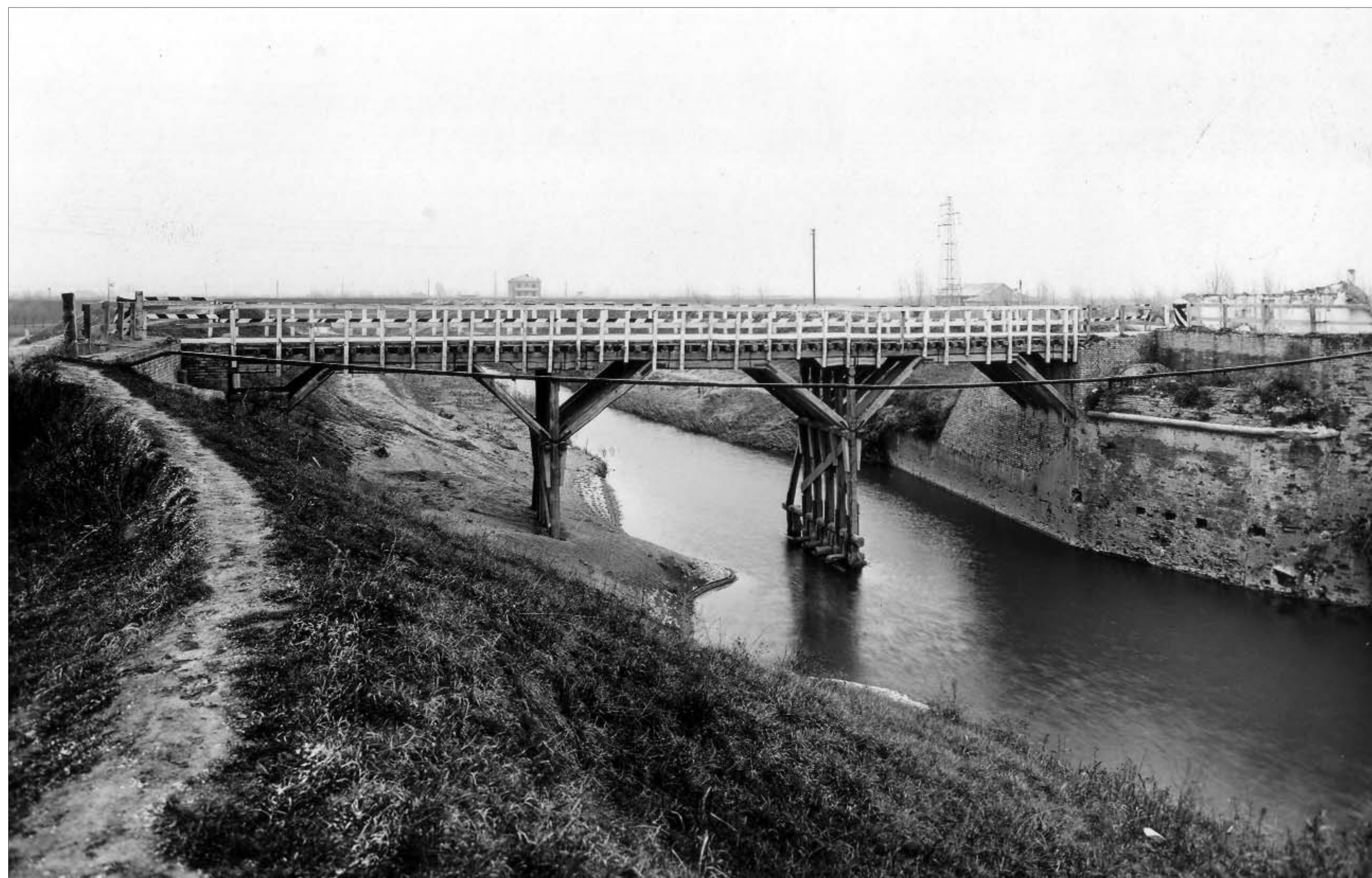
Ripresa fotografica del ponte ligneo sul torrente Samoggia, sulla strada di S.Giovanni in Persiceto (ASPB)
