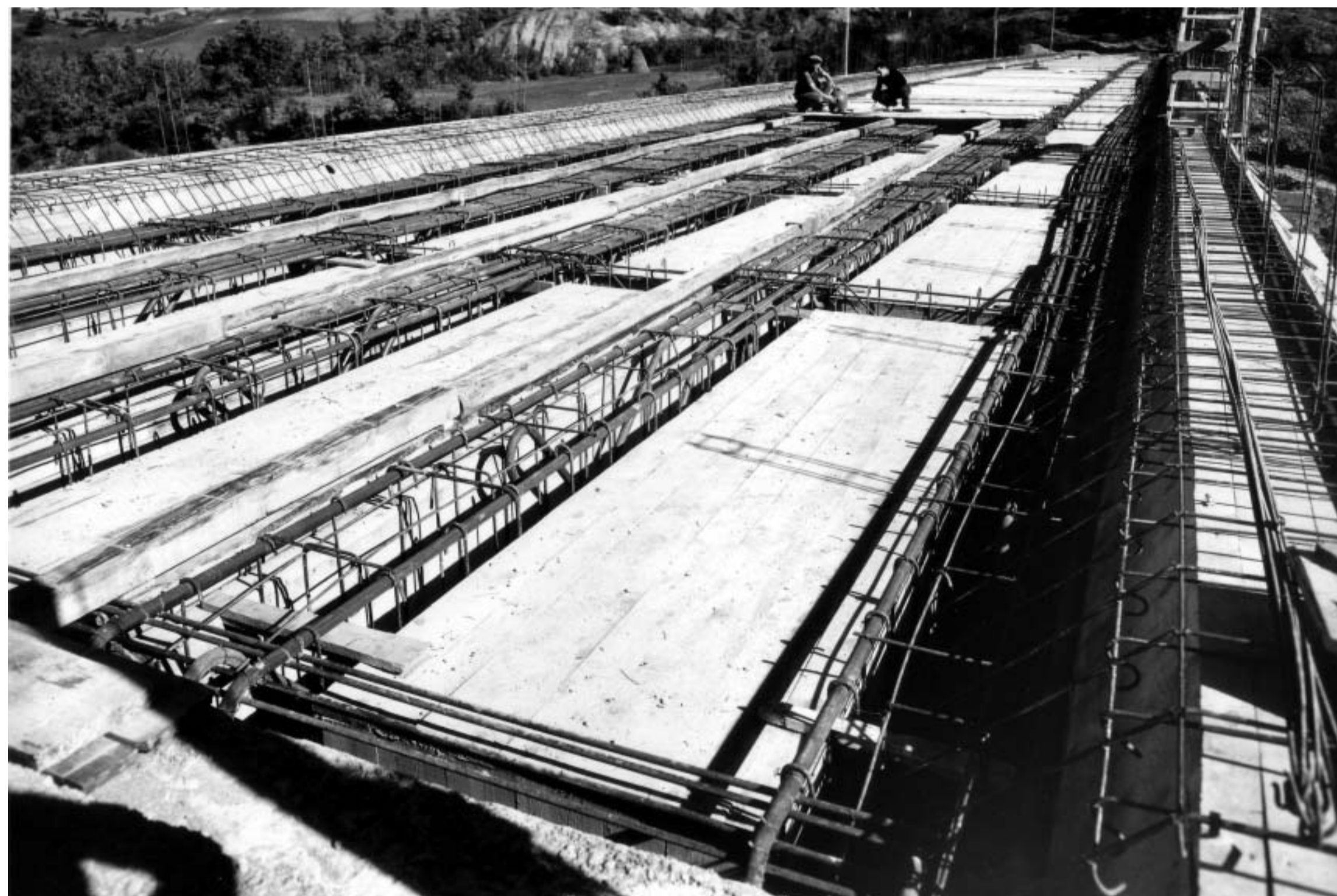
Particolare dell'impalcato del ponte sul Dardagna (Foto Studio A. Villani, Bologna, anno 1949-ARER)
