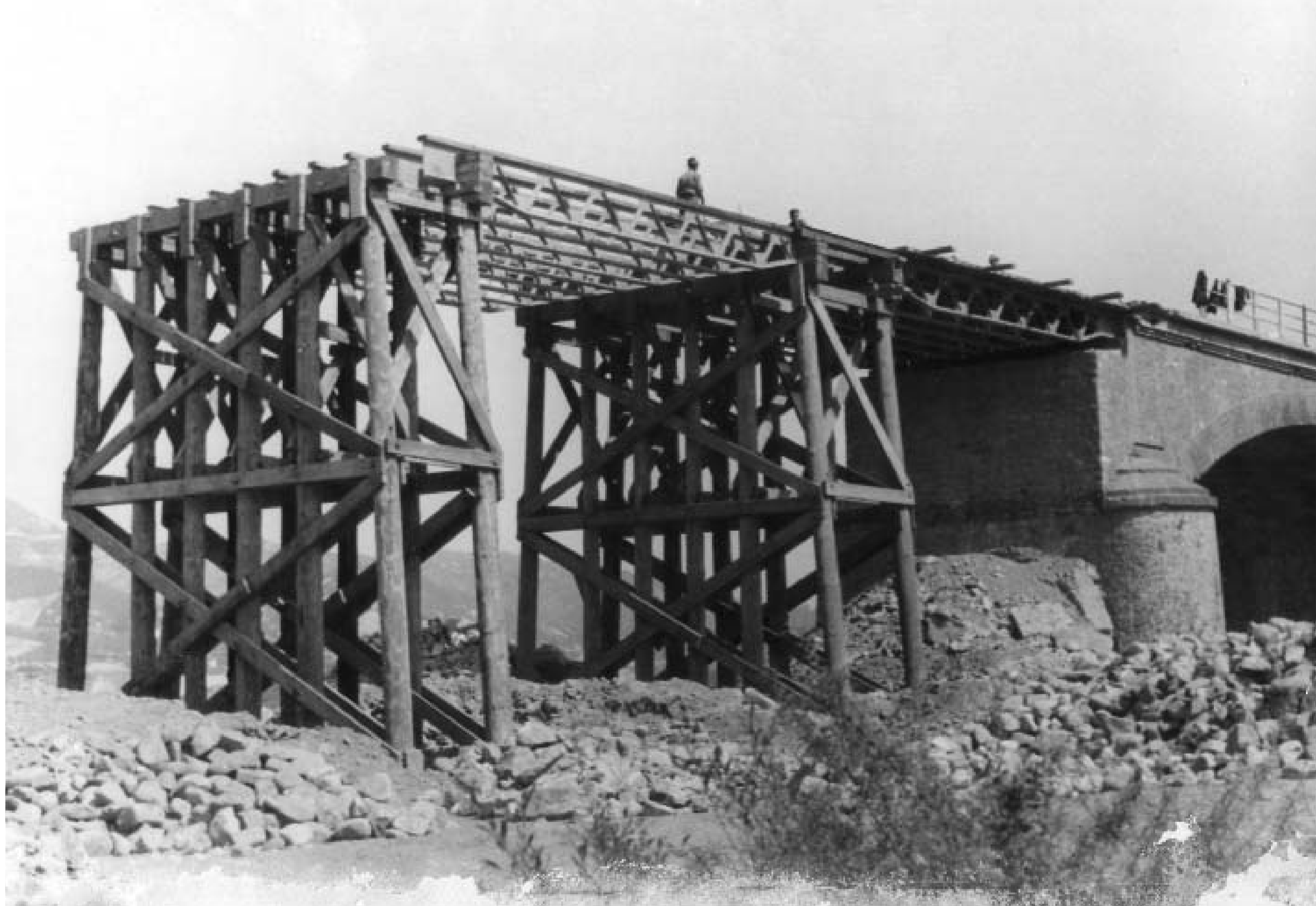
Vista in primo piano delle travi "Flambo" sorrette dal doppio sistema di palafitte lignee del ponte Locatello (ASPB)
