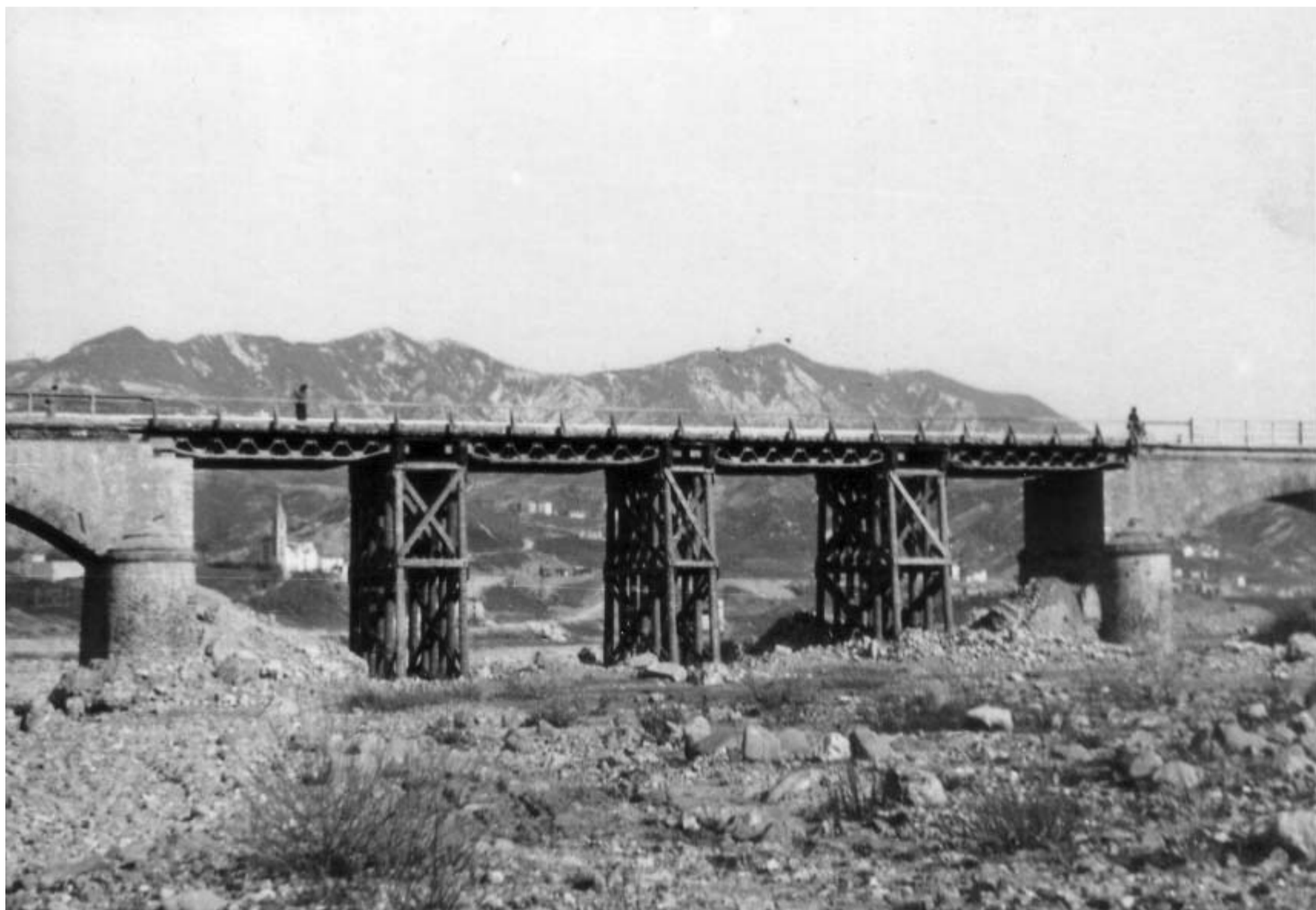
Il ponte provvisorio a lavori ultimati (ASPB)
