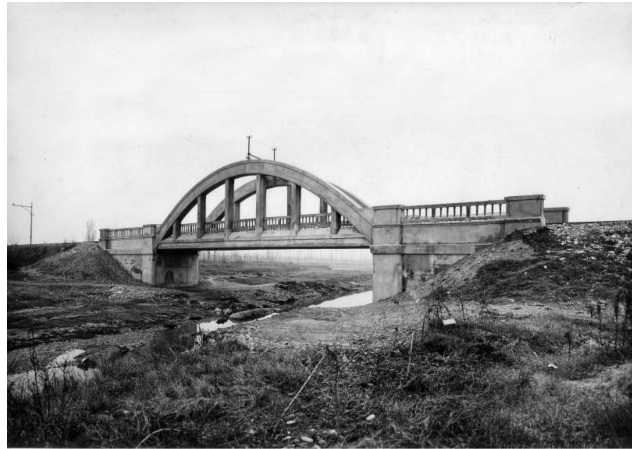
Ponte sul torrente Lavino, della ferrovia Casalecchio Vignola (ASPB)
