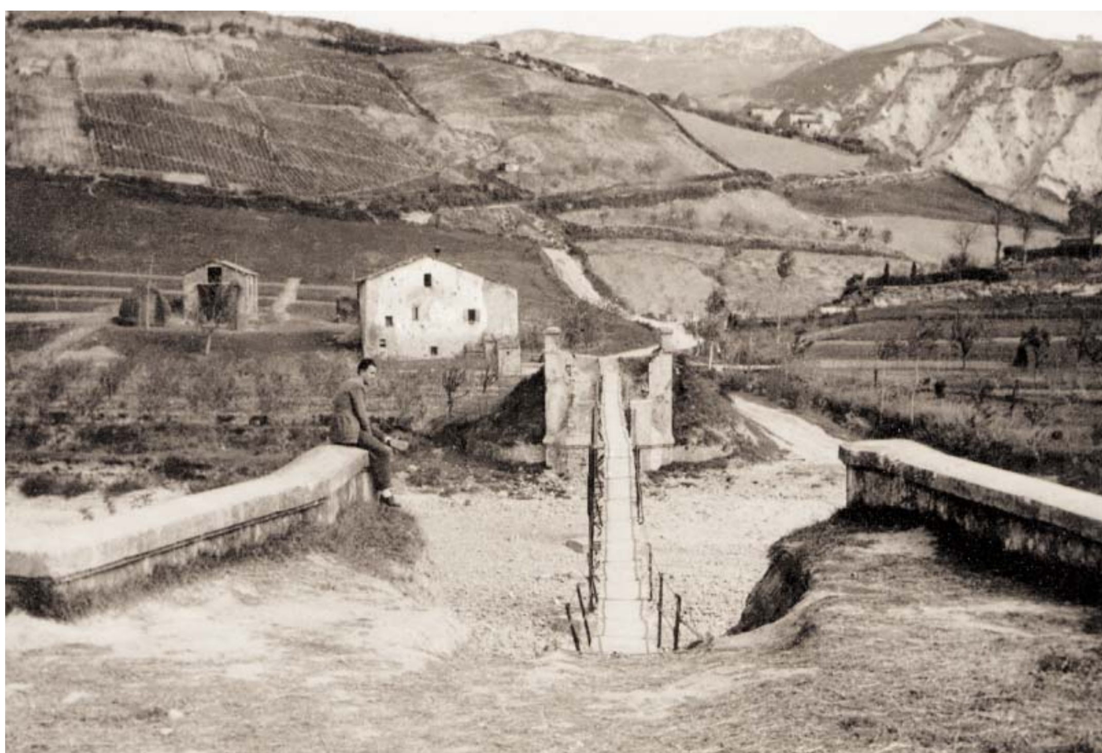
Una passerella costituisce un provvisorio passaggio sul Santerno dopo la distruzione bellica del ponte presso Prato (foto A. Sveltini)
