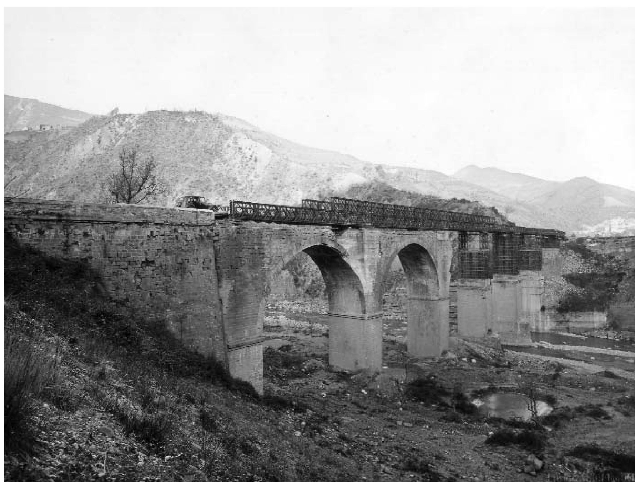
Il ponte di Valsalva a lavori terminati (ASPB)
