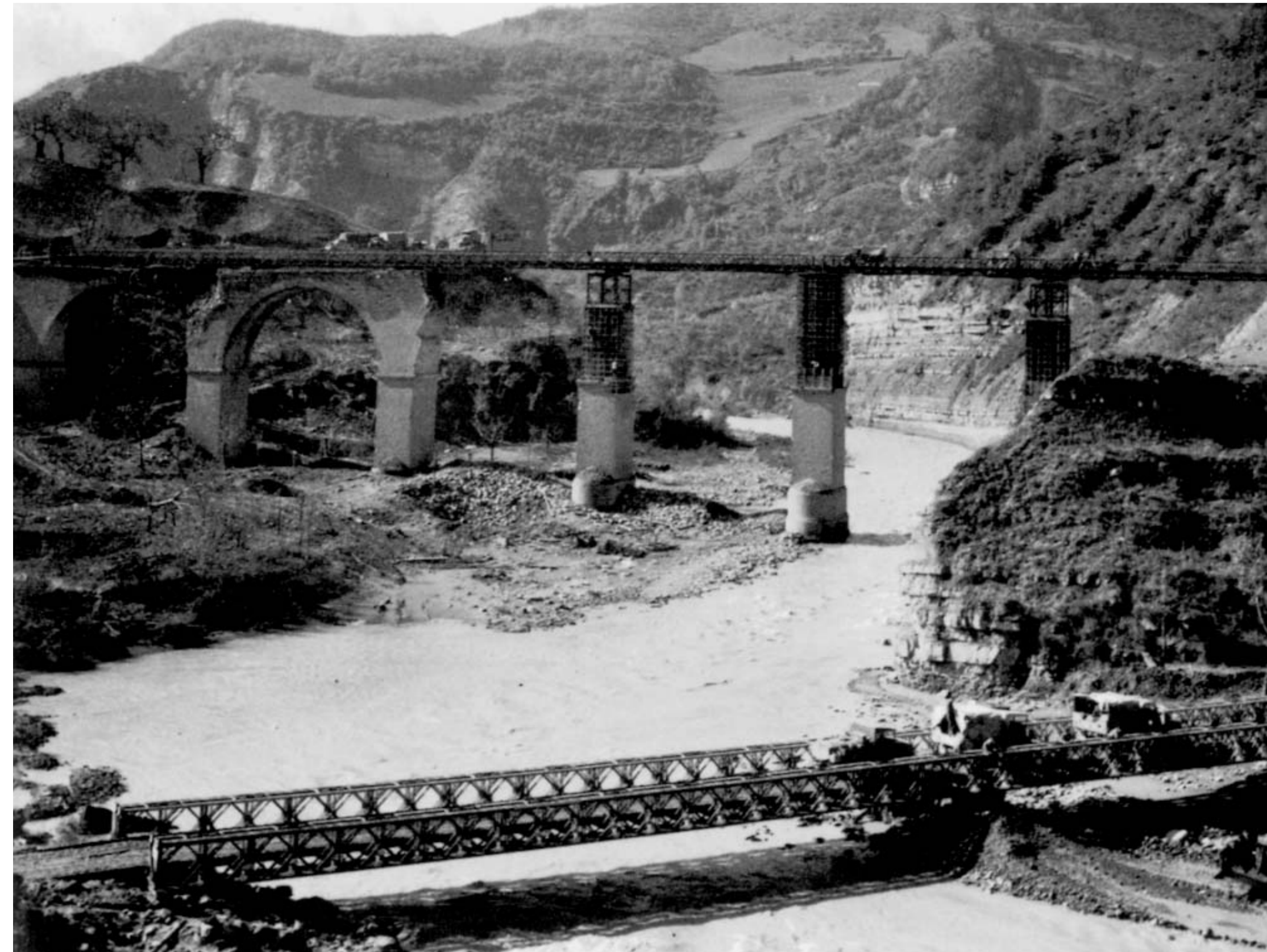
Ricostruzione del ponte di Valsalva sul Santerno da parte dei genieri alleati. In basso sulla foto è visibile un ponte Bailey sul quale è dirottato il traffico militare. Foto datata 19 ottobre 1944. (I.W.M. London)
