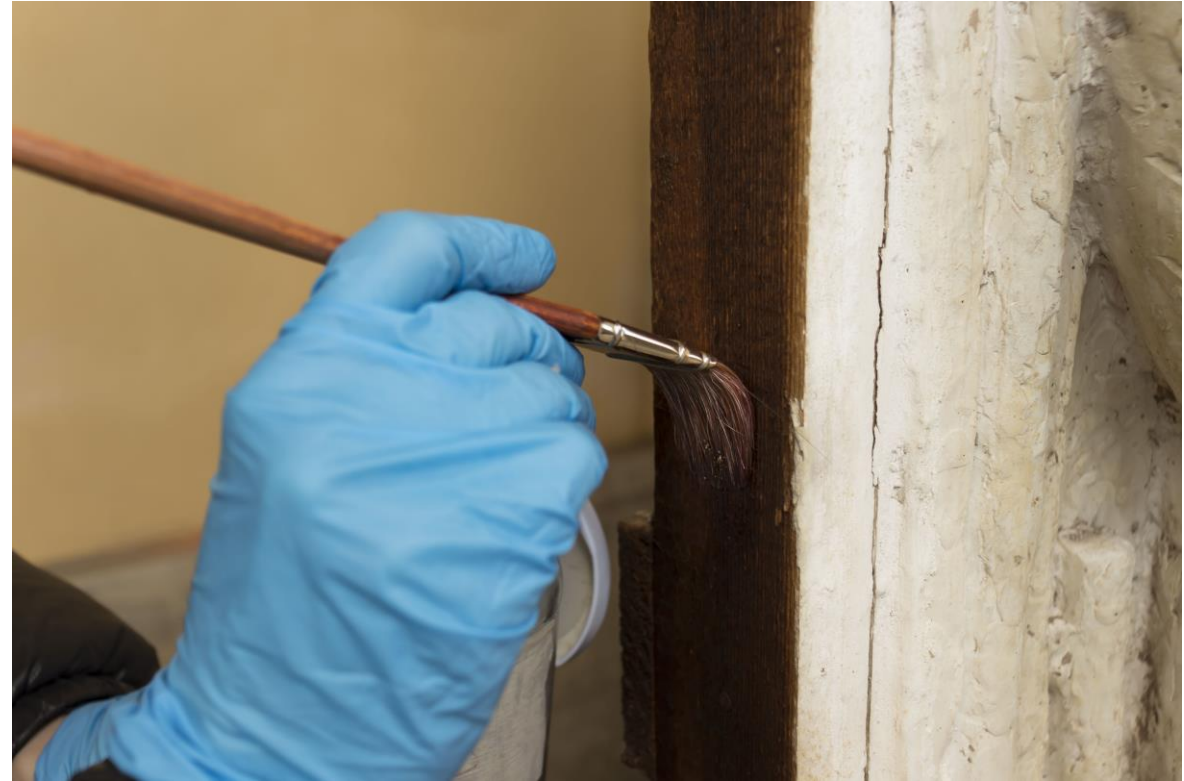
Applicazione di Xilores pronto per prevenire attacchi di insetti xilofagi sulla cornice lignea.
