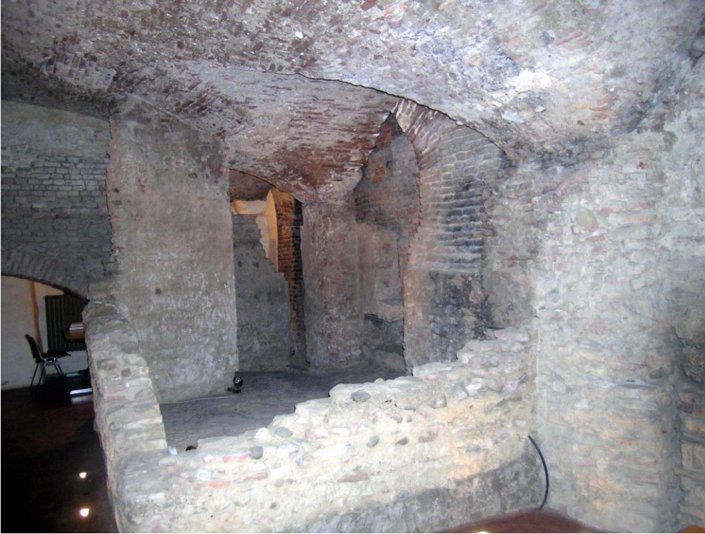
Panoramica delle strutture più antiche del c.d. rudere.
