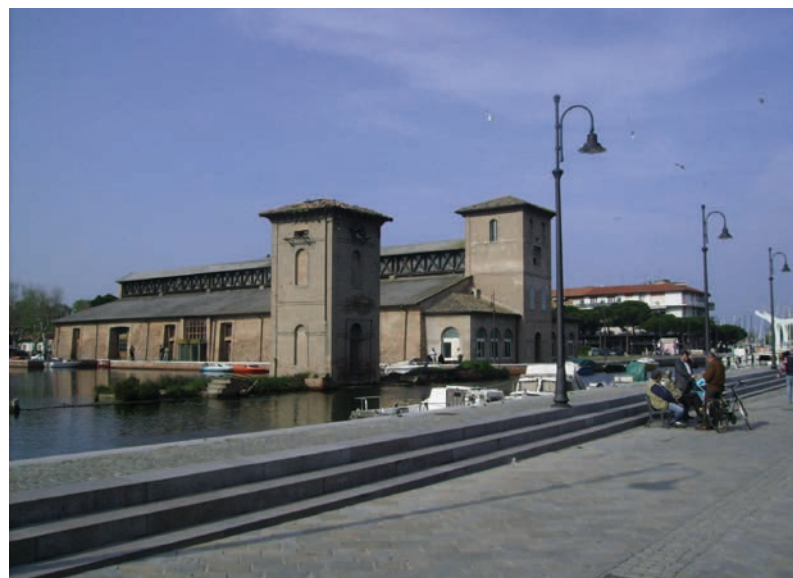
Cervia (RA): »Magazzino Darsena« (»Skladišče Notranje pristanišče«): pogled na stavbo (foto Assorati)
