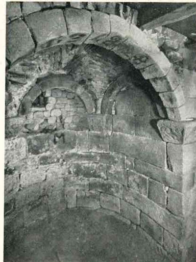
A sinistra: Abside centrale della cripta. Sia le colonnette che i capitelli sono mancanti. A destra: Abside laterale destra. È l'unica abside con copertura originale. La volta è a crociera, costituita di « mattoni » di arenaria messi di taglio.
