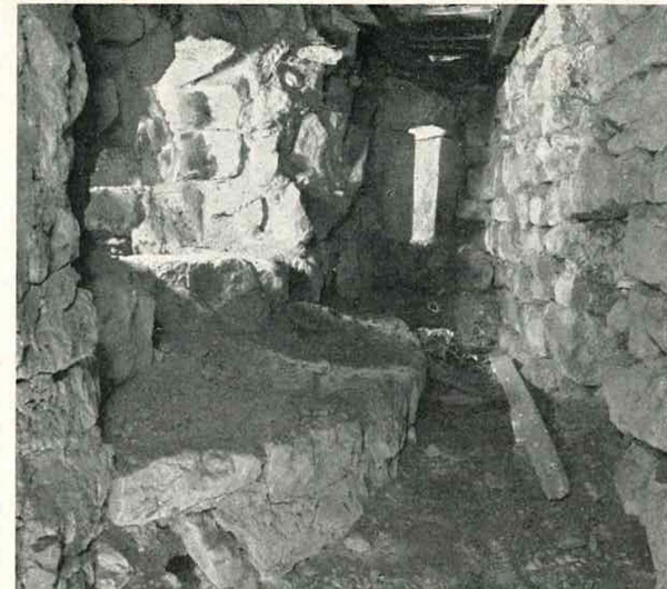
Esterno dell'abside laterale destra. Si può notare il basamento originariamente esterno. Alla destra è visibile il muro del fondo della chiesa sovrastante.
