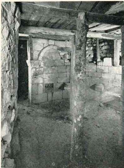
A sinistra: Abside centrale della cripta. Sia le colonnette che i capitelli sono mancanti. A destra: Abside laterale destra. È l'unica abside con copertura originale. La volta è a crociera, costituita di « mattoni » di arenaria messi di taglio.
