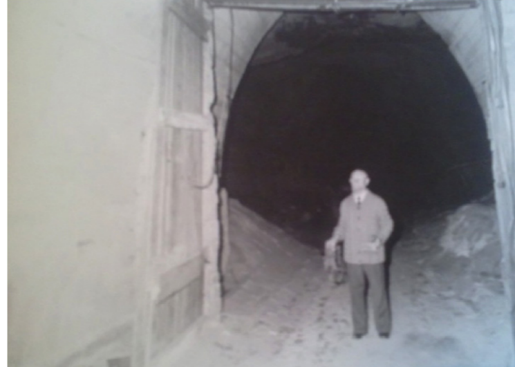
L'ingresso di una galleria
